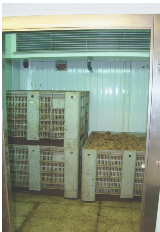
Foto 1.- Colocación de las cajoneras en la cámara.
