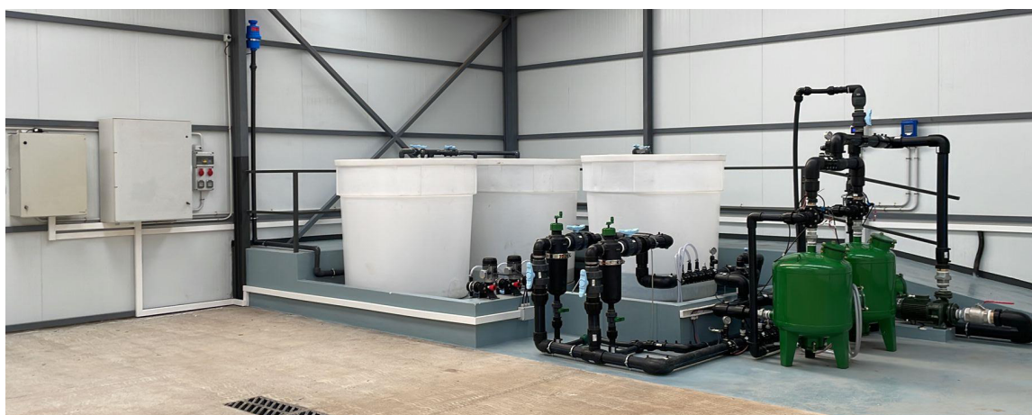
Nuevo Cabezal de riego demostrativo en la Finca de la Quinta
