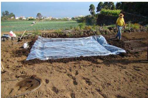
Foto 19.- Colocación de plástico.
