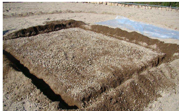
Foto 14.- Superficie preparada para colocar el plástico.
