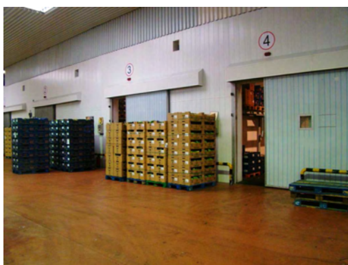
Foto 7.- Vista general de las cámaras de maduración y conservación.
