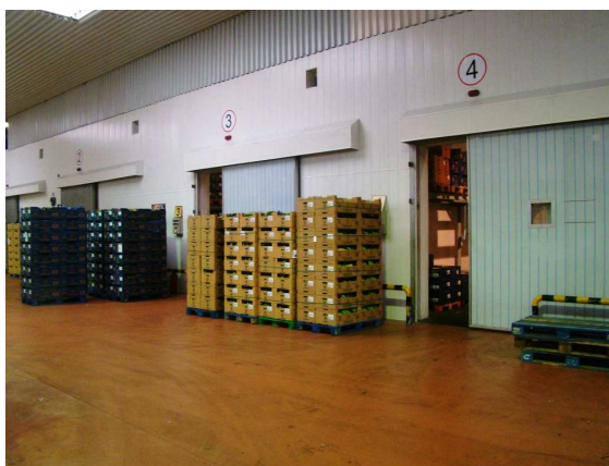
Foto 6.- Vista general de las cámaras de maduración y conservación.
